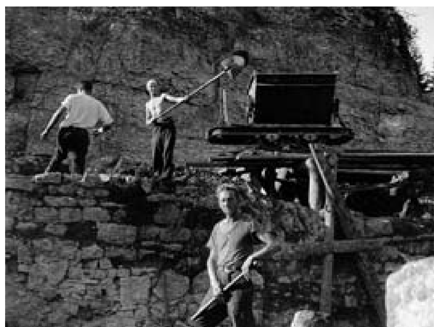
Ausgrabungsarbeiten 1934/35. Insgesamt arbeiteten rund 200 Mann während fast 11 000 Tagen. Es wurde mehr als 3000 m 3 Erdreich und Schutt aus der Burgruine befördert.
